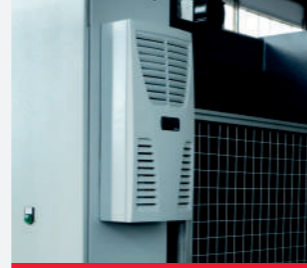
Elektrik Kabin Soğutma Sistemi
